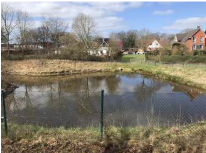
Auch die Regenwasseranlagen verursachen hohe laufende Kosten
